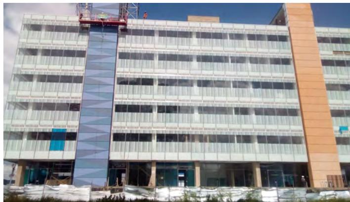
El acabado final fue conformado con una masilla llamada **Skimlt™** es un material listo para usar, diseñado para alisar la capa base reforzada de Dryvit sobre la lámina aislante, aplicado con llana.
