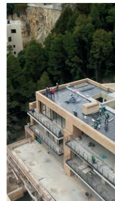
En los balcones se aplicaron 740 m<sup>2</sup> de sistema Vulkem Peatonal en color gris, y en los tanques de agua se instalaron 237 m<sup>2</sup> de EUCO MEMBRANA TANQUES PVC.
